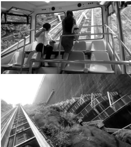
写真1・2 インクラインを活用した昇降施設。
