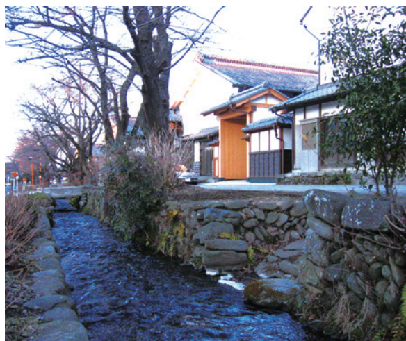
市中に張り巡らされている雄川堰は地元自治体により日常的な管理がされている（群馬県甘楽町）
